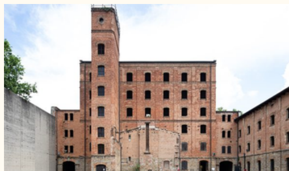
Edificio centrale a sei piani con torre.
